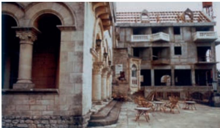
La construction de la nouvelle aile à compter de 1977, coll. G. Cormau
