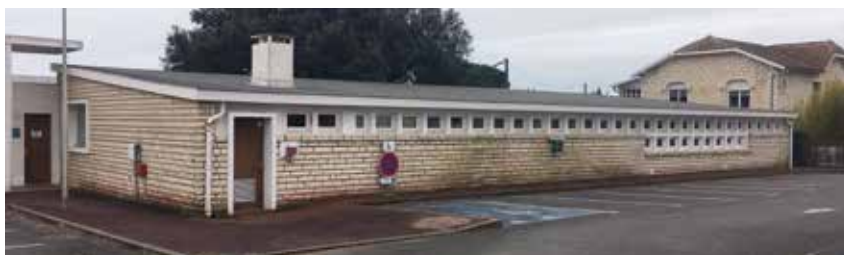
Ancienne école maternelle construite en 1953-1954, façade nord
