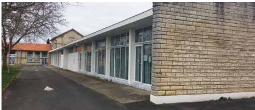
Ancienne école primaire construite en 1953-1954, façade sud
